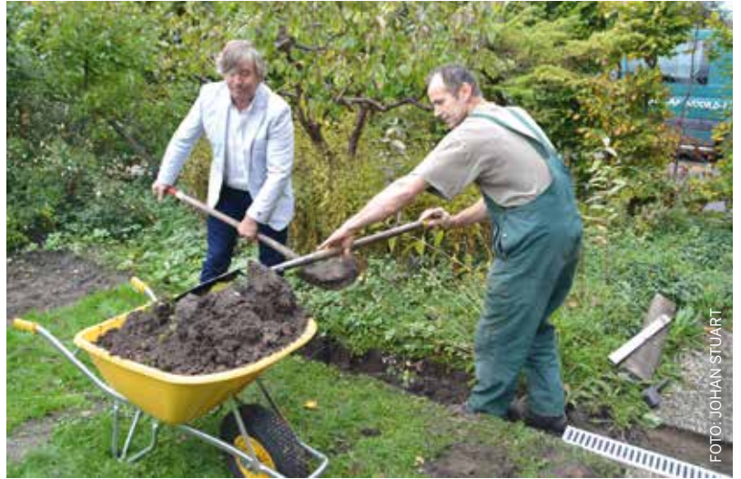
▲ Wethouder Leo van Schoonhoven (links) helpt bij de aanleg van een regenwatertuin.
